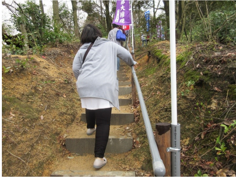
参道の階段の整備・のぼり立ての取り付け
